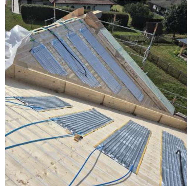
Kühldeckenpaneele bei Dachsanierung von Aussen
